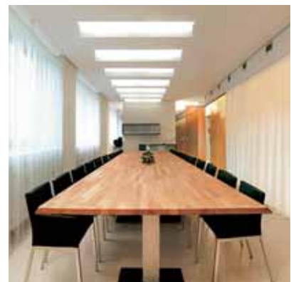
Vergaderzaal verlicht met dubbelfocus diffusor armaturen. Functioneel en zacht licht uit een lichtspleet.
