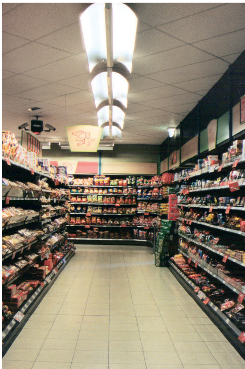
De zwaluw reflector geeft een efficiënte lichtbundel naar links en rechts op de schappen. Foto: Van DOORN Verlichting - Culemborg.
